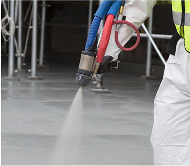
Antes de la reconstrucción, Tab Associates necesitaba encontrar una barrera climática que hiciera el trabajo. Necesitaban que la barrera fuera perfecta, para sellar alrededor de sujetadores, e impermeable al agua líquida. Además, ya que la barrera de humedad anterior había sido instalada incorrectamente por el arquitecto original, Tab Associates quiso encontrar un producto que contara con soporte de servicio técnico que les ayudase a hacer el trabajo bien la primera vez.
